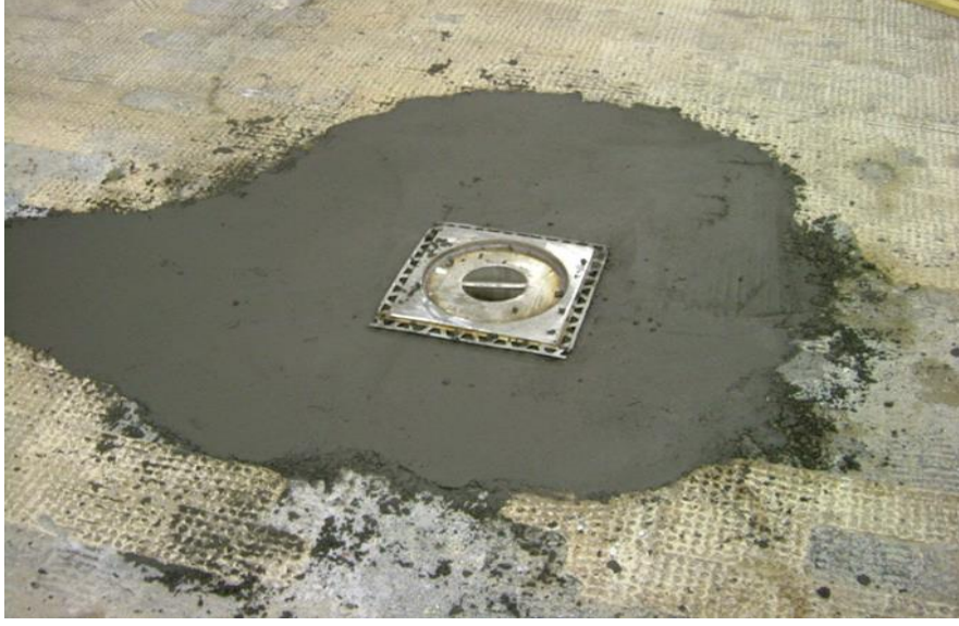
Drenaj çıkışı, ARDEX A45 ile tamirâtı.
